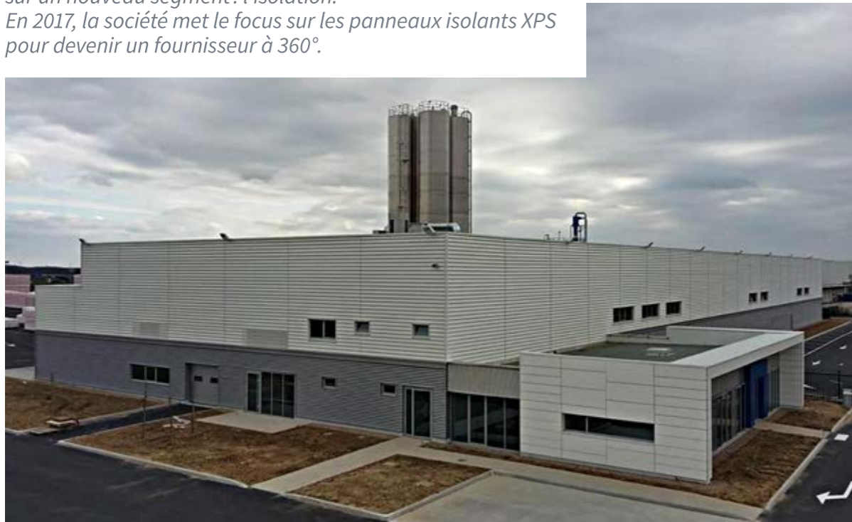
La nouvelle usine de Savigny
