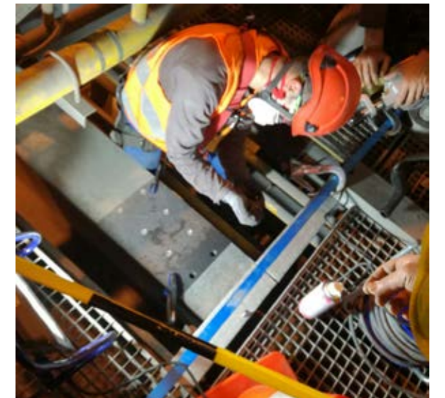
Renforcement structure sur l'usine Guardian en Allemagne
